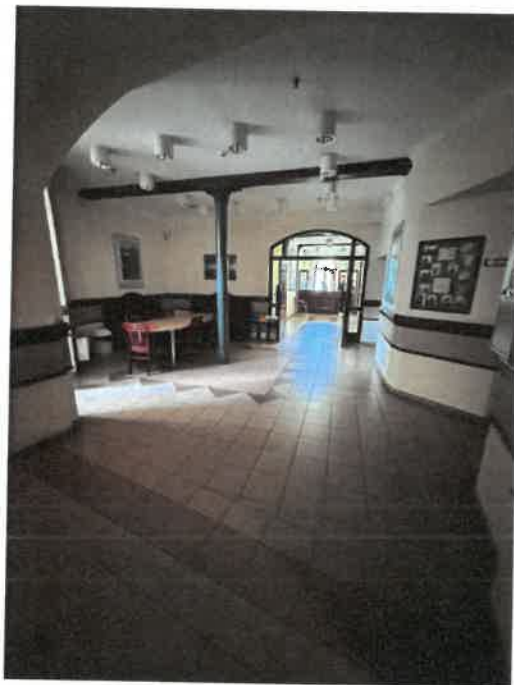
Zdjęcie nr 2 Widok na istniejące słupy stanowiące element konstrukcji nośnej, niezabezpieczone do klasy odporności ogniowej R120.
