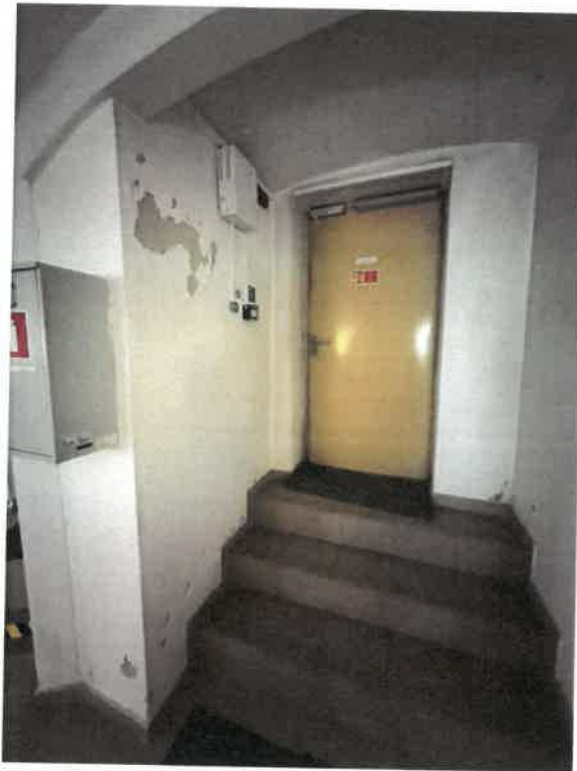
Zdjęcie nr 4 Widok na wyjście ewakuacyjne z poziomu piwnicy zawężone do wartości 0,95 m oraz nieprawidłową szerokość spocznika schodów stałych 0,38 m.
