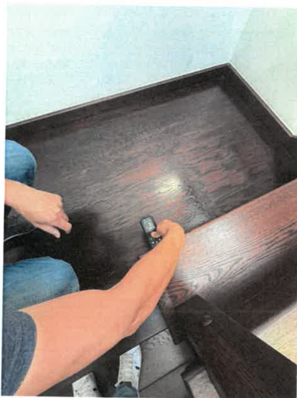
Zdjęcie nr 3.1, 3.2 Widok na schody drewniane prowadzące na poddasze, o nieprawidłowych parametrach technicznych biegów i spoczników schodów.
