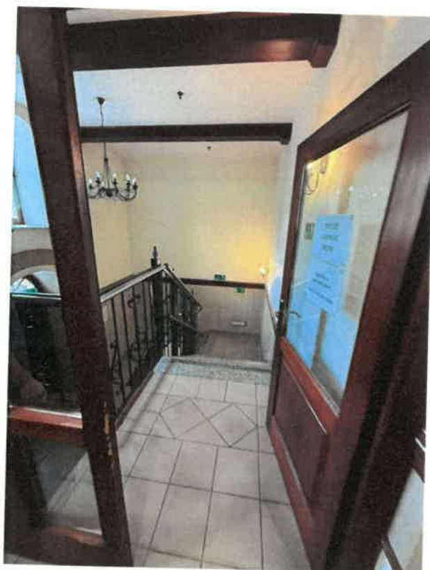
Zdjęcie nr 6 Widok na drzwi prowadzące na schody stałe w poziomie parteru (korytarz – pom. nr 0.07) o szerokości w świetle poniżej wymaganych 0,9 m.
