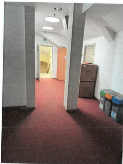
Zdjęcie nr 5 Widok na widoczne drewniane elementy konstrukcji dachu nieobudowane przegrodami o klasie odporności ogniowej EI 60, występujące zawężenie drogi ewakuacyjnej oraz wykładziny o nieustalonej klasie reakcji na ogień.
